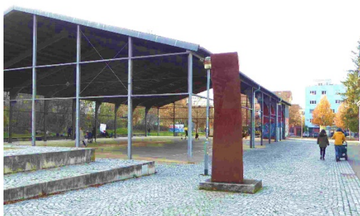
Panzerhalle - Blick nach Westen
