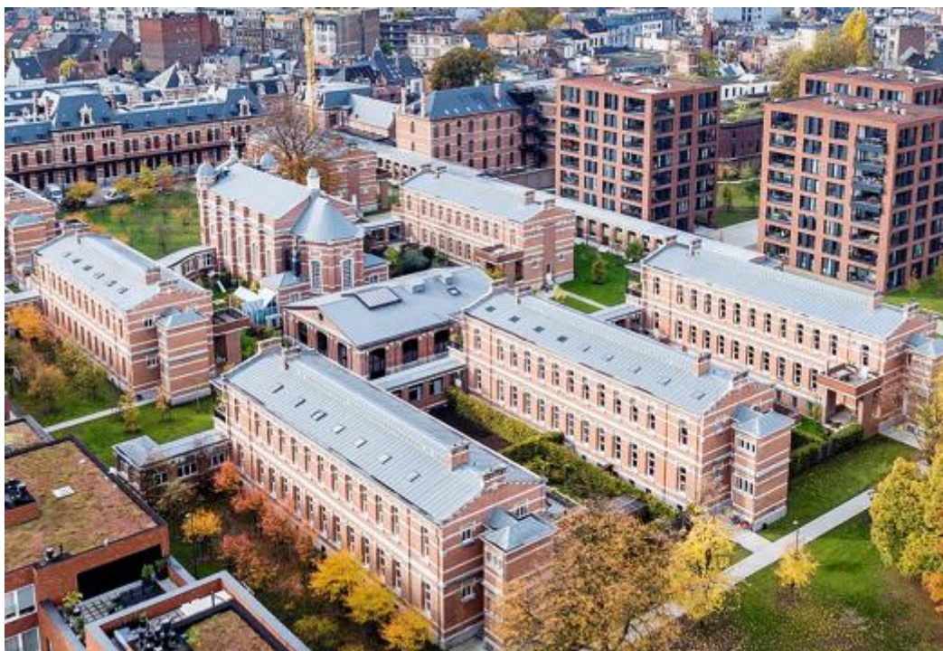
Le projet de réhabilitation de l’hôpital militaire d’Anvers, une volonté de renouveau urbain de Matexi.
