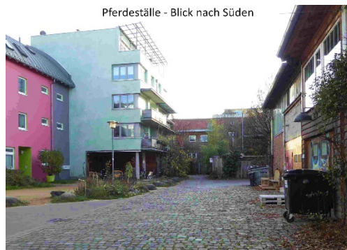
Pferdeställe - Blick nach Süden
