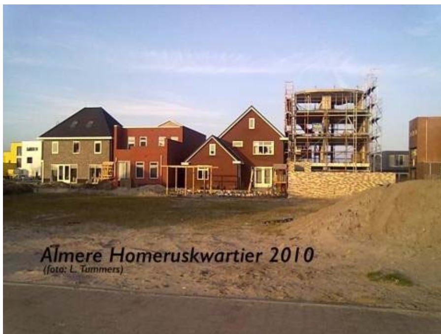
Construction du quartier Homerus à Almere en autopromotion individuelle
