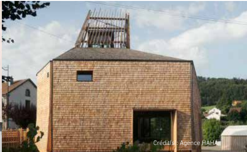
Crédit(s) : CO-BE Architectes.
