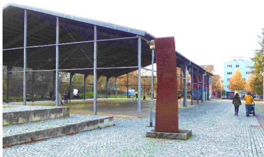
Panzerhalle - Blick nach Westen
