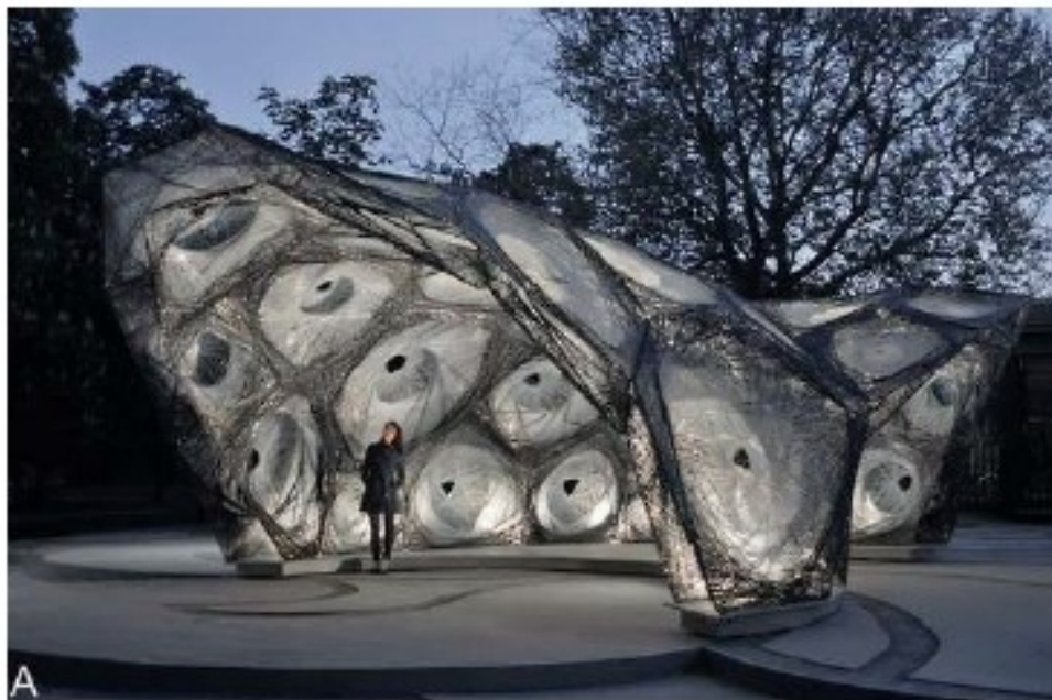
Figure 4.b : La structure temporaire Elytra Filament Pavilion sur le campus de l'Université de Stuttgart.
