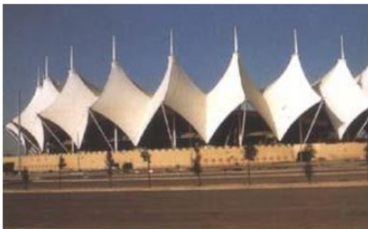
Horst Berger, King Fahd Stadium de Riyad, Arabie Saoudite, 1985 galerie photos des structures tendues du NJIT http://www-ec.njit.edu/civil/fabric
