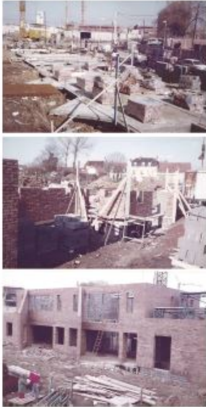
5.5 - Hagrobi - Photographies de chantier
