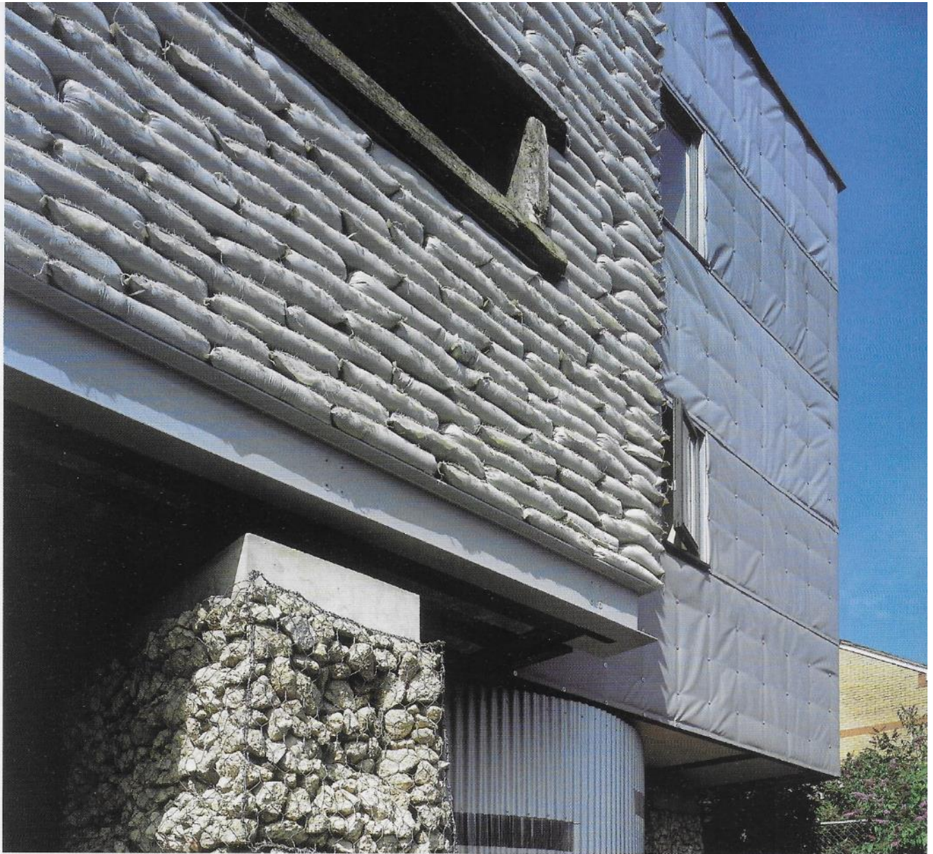
MUR DE SABLE ET PYLÔNES DE GABIONS - © Paul Smoothy
