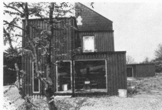
Revêtement de façade en acier corten.
